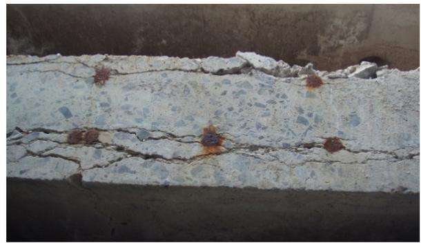
a) コンクリート床版鉄筋位置におけるひび割れ
